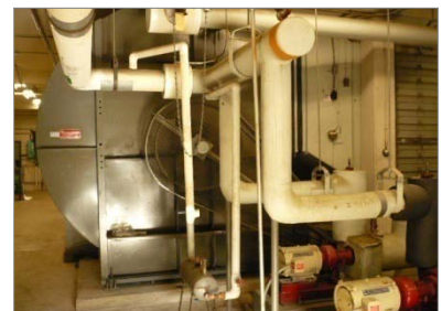
Roof AHU return fan
