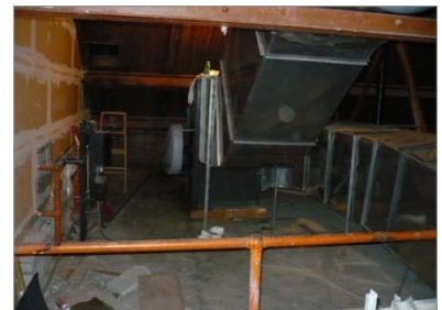
Center exhaust fan system
